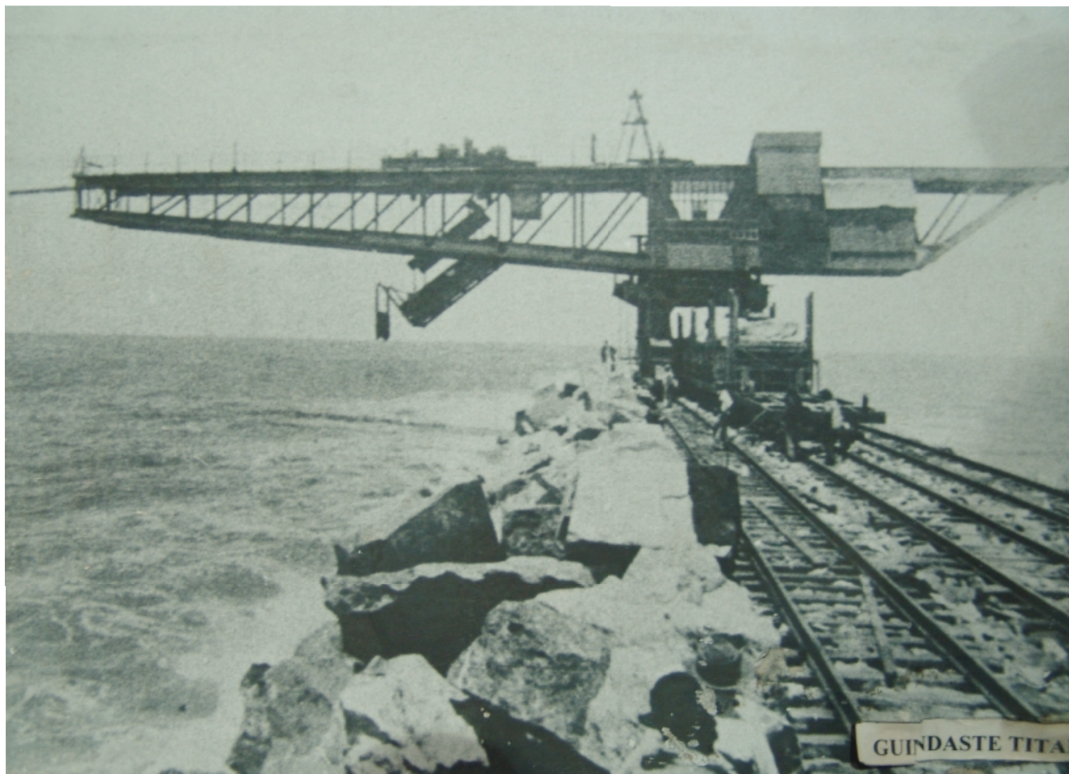
Titan atuando na construção dos molhes por volta de 1912.
